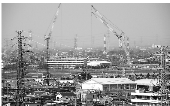
建設中の新総合太田病院（仮称）
